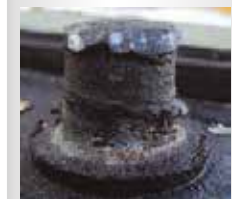
GOLPEADO Golpes directos o al golpear el poste cuando no se abre correctamente la terminal.
