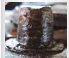
HUNDIDO Por golpes directos al poste o tornillo.
