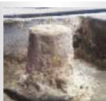
SULFATADO Ocasionado por un golpe.
