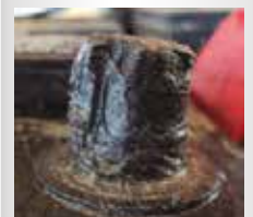
EXCESO DE SUJECIÓN Por terminales demasiado apretadas.
