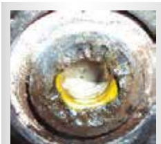
FUGAS Y DEFORMACIÓN DE TERMINAL Exceso de apriete y/o tornillo inadecuado.
